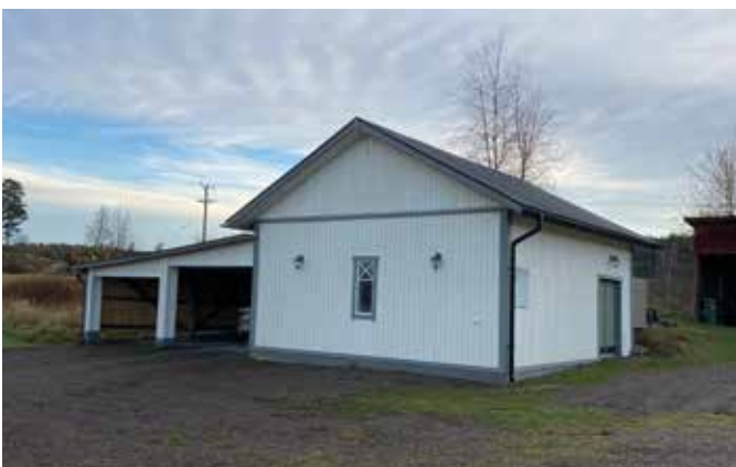
De gerenoveerde garage/carport
